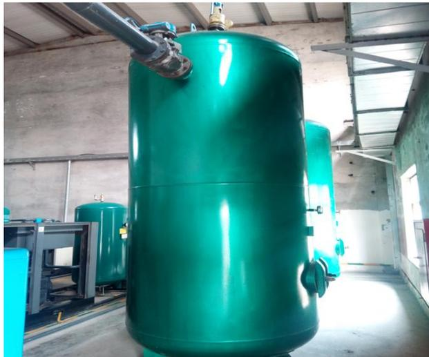
为更好的配合公司设备自动化提升，提高压缩空气的利用效率，公司对空压系统进行改进提升，通过优化空压机，提升压缩空气压力稳定性，降低电能消耗。
