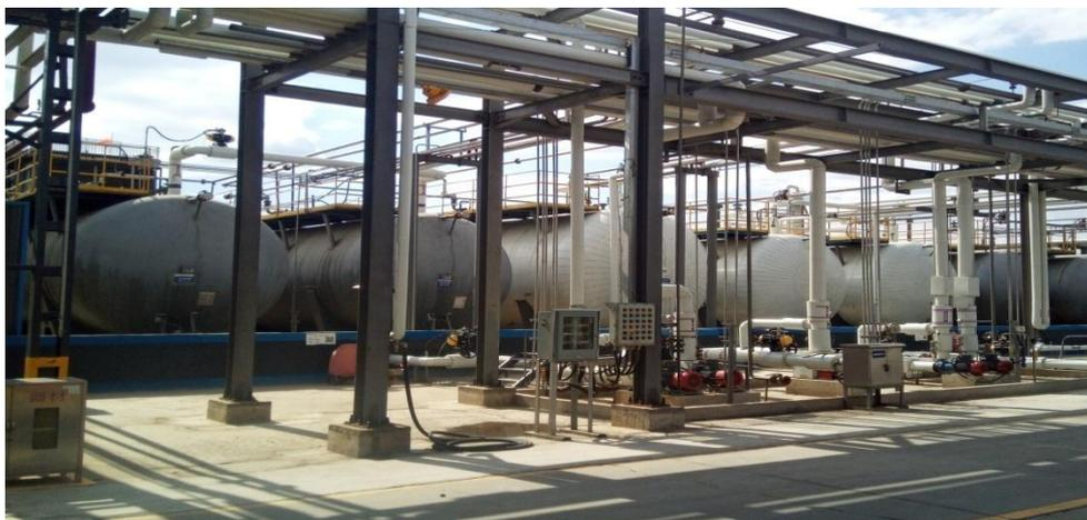
2021年，科迈天津对罐区进行了合规性提升改造，进一步提升安全性、呼吸系统增加吸收，之后进行焚烧，减少有机物排放。
